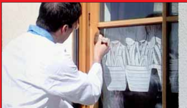
Aplikácia renovačných náterov pri krycom systéme renovácie.
